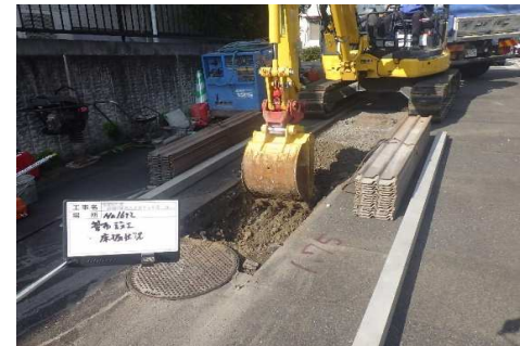
荘園6組外污水幹線管きよ布設工事
