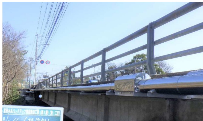
寒原水系バックアップ施設築造工事 (第1期)(第1工区)
