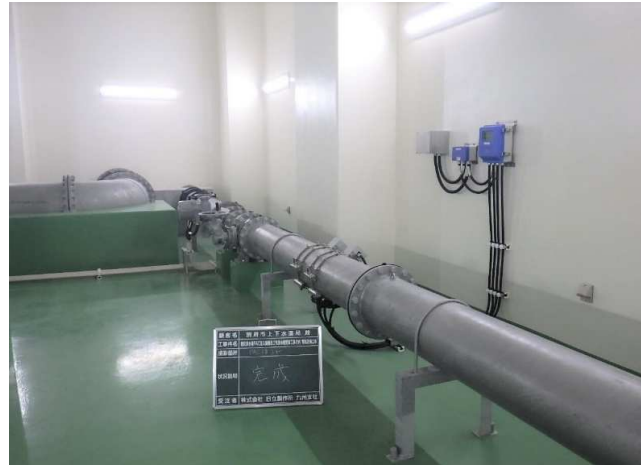
朝見浄水場PAC注入設備及び洗浄水槽更新工事の内電気設備工事
