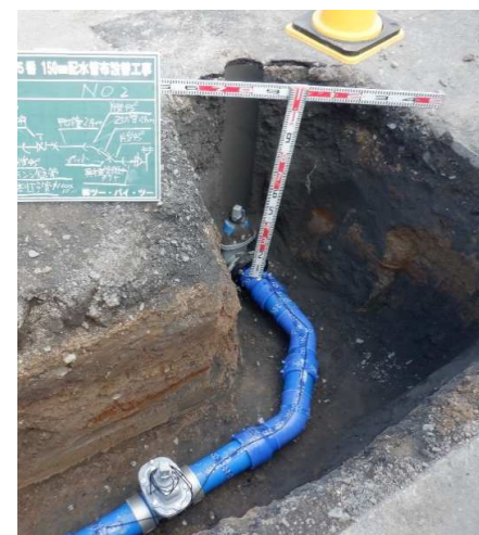
光町5番 150mm配水管布設替工事
