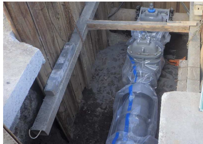
新鮎返～野口原 300mm送水管布設工事
