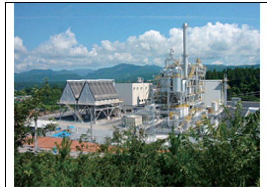
日田ウッドパワー(日田市) 最大出力:12,000kW 木質専焼の発電所。発電効率は約27%
