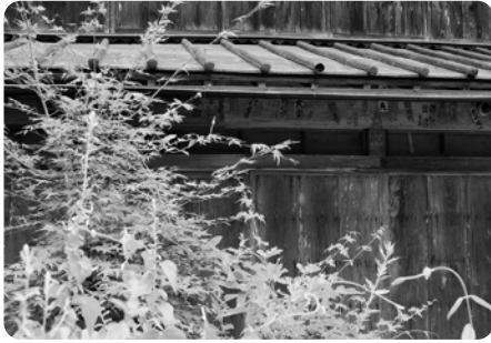
《空き家利活用などの対策は》
