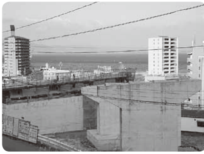
— 建設が進む別府〜挾間線 —
