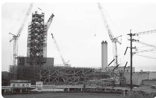
— 新たな焼却炉の建設が進む藤ヶ谷清掃センター —
