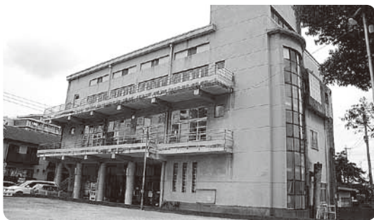
— 解体が決まった現在の不老泉 —
