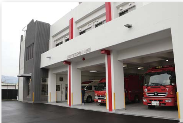
◀消防署亀川出張所建替工事
