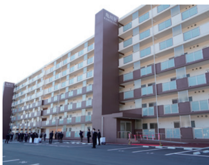
▶市営亀川住宅
