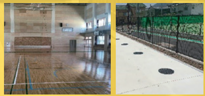
体育館(1階)と屋外マンホールトイレ 非常時は避難場所となる体育館、屋外にはマンホールトイレを設置しています。
