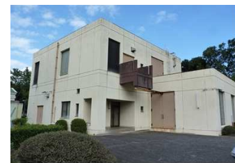
汐見中継ポンプ場
