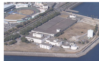
中央浄化センター
