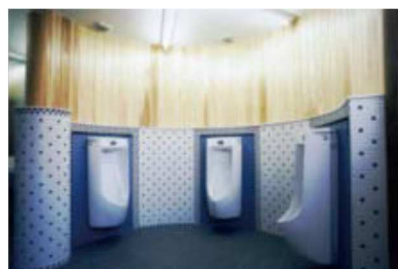
ドアをなくし、床をドライ方式に改修 【東京都世田谷区立山崎小学校】
