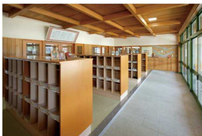
昇降口の段差を解消
