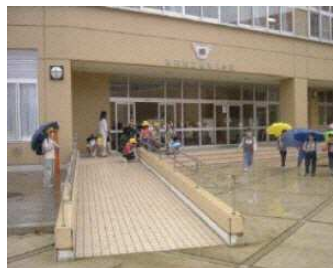
スロープの設置
