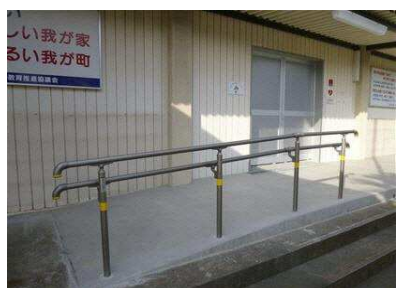
スロープの設置
