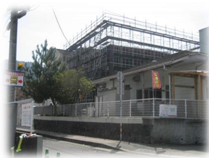
昇降口棟新築工事
