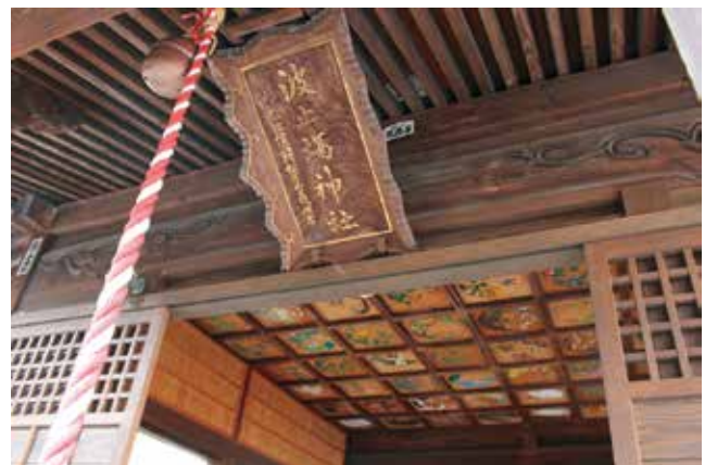
波止場神社 社殿 (格天井)
