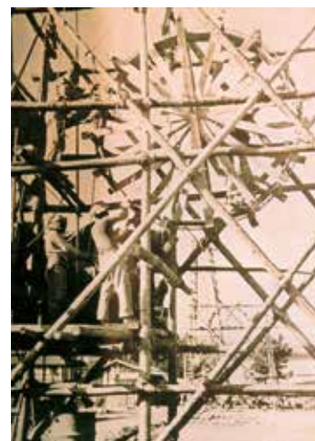
作業の様子（奥にも櫓が見える）
