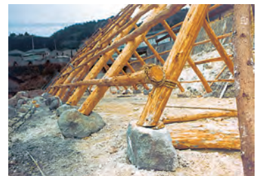
丸太の柱とヤナカの骨組み
