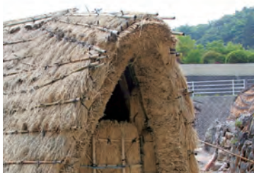
温度・湿度を調節する三角窓の通気口
