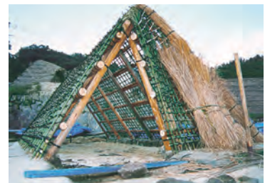
茅とわらで雨漏りがないよう覆う
