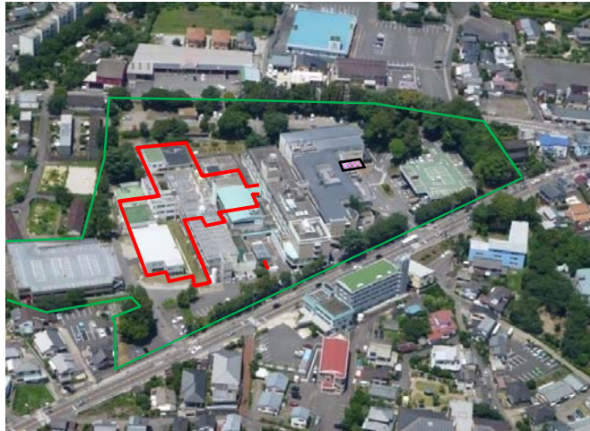
新病棟部の既存病棟については撤去。
