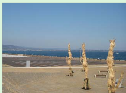
▲海の玄関口である別府国際観光港(整備中の第4ふ頭)
