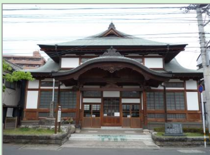
▲文化財の亀川浜田温泉資料館
