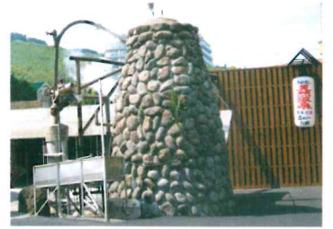
景観に配慮した噴気施設
