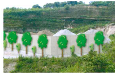
周辺に配慮した物件の堆積例
