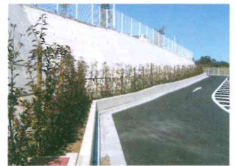
擁壁の前面に植栽を行った例
