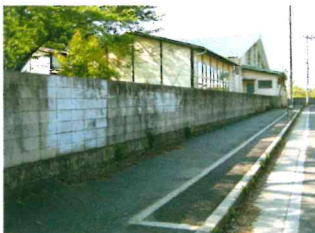
ブロック塀により閉鎖的な空間となっています。
