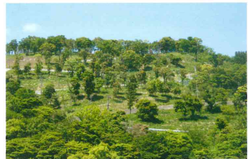
植生により擁壁などを覆いかくします。
