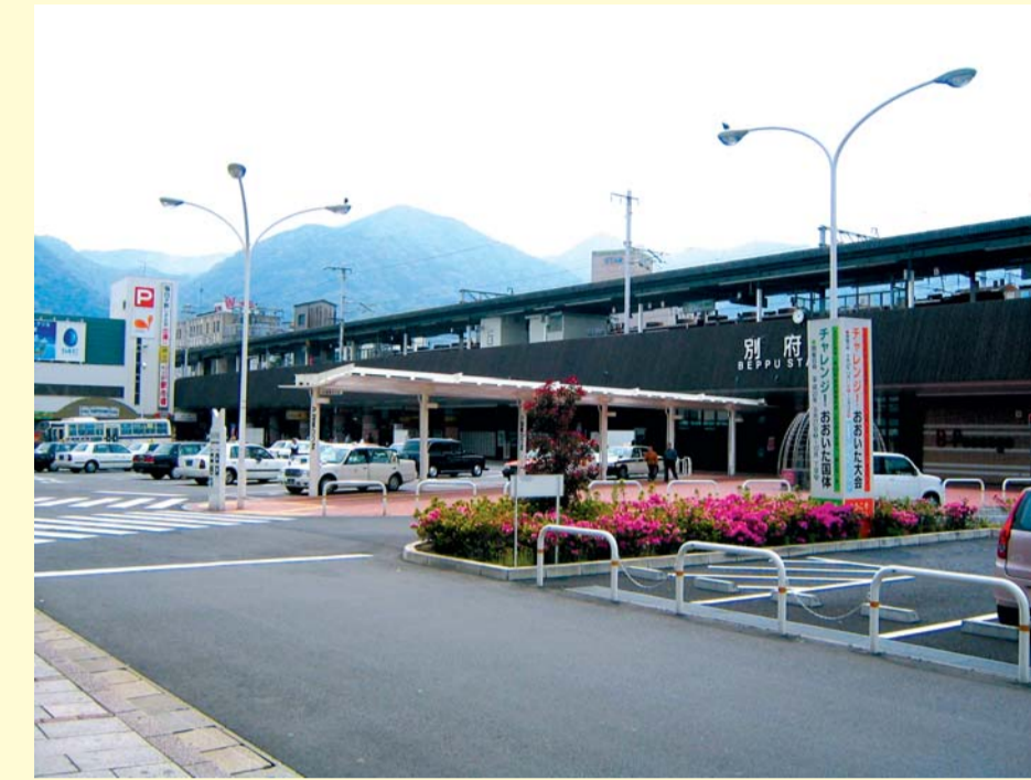
リニューアルされた駅舎と東口駅前広場
