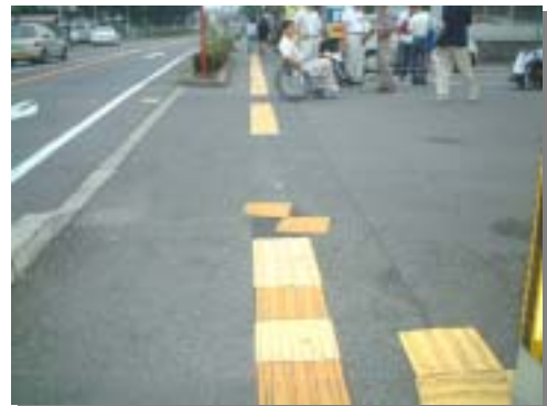
とぎれている視覚障害者用誘導ブロック
