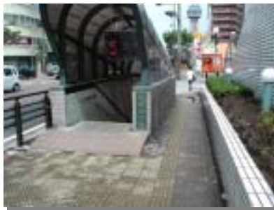
国道 10 号横断地下道
