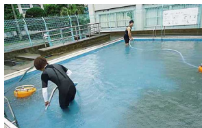
プール内に堆積した火山灰の除去 (桜島、鹿児島市提供)
